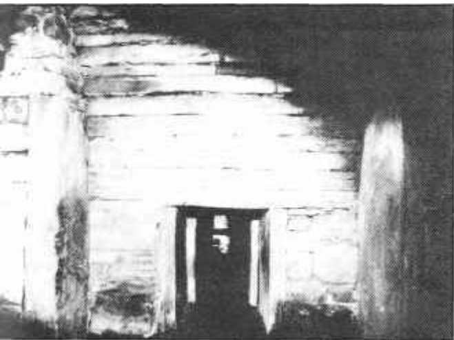
Maes Howe u Orkneyju: grobna komora; zidovi su građeni kao suhozid od kamenih blokova koji tijesno prijanjanju
